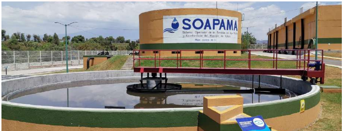
Planta de Tratamiento de Aguas Residuales SOAPAMA
