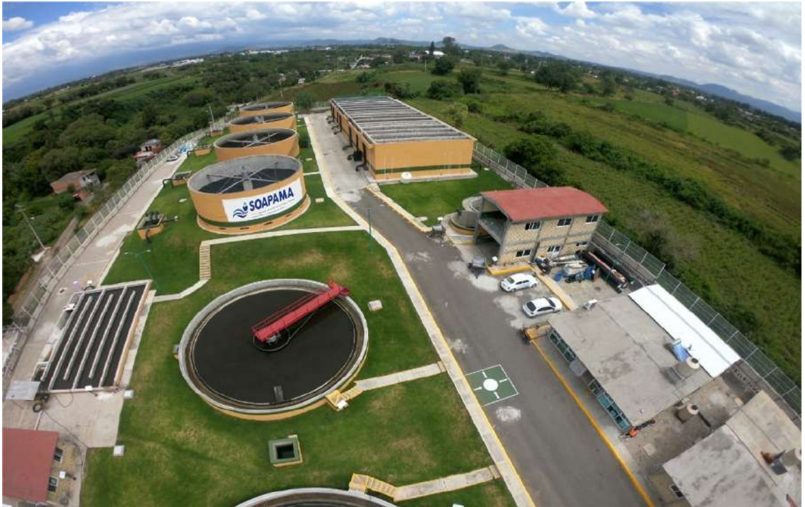
Panorámica de la Planta de Tratamiento de Aguas Residuales "Cantarranas"
