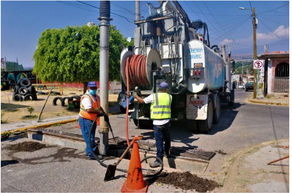
Maquina de Desazolvadora
